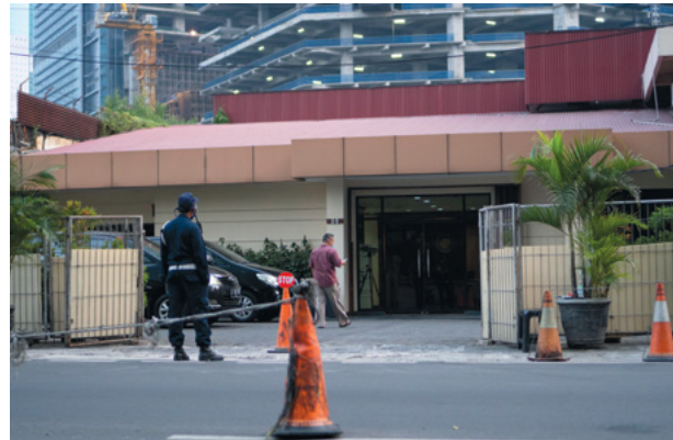
Gambar 23. Gedung kantor terkait RGE di Jl. Teluk Betung No. 36
