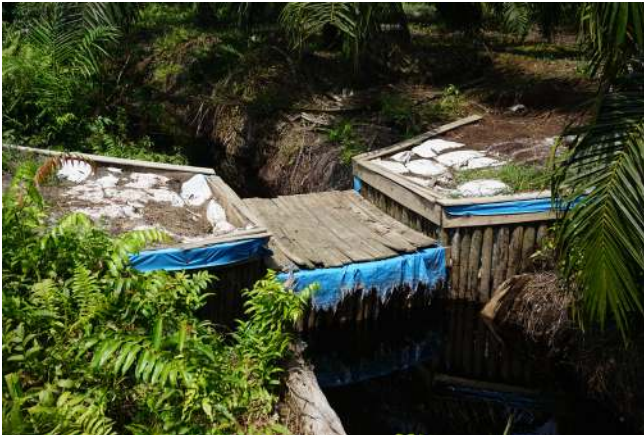
Foto: Sekat kanal yang masih berfungsi di Sungai Sigajah. Koordinat N 02 2' 1.612" E 100 34' 41.311"
