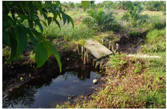
Foto sekat kanal yang rusak dan kering. Koordinat: N 138' 30.077" E 101 44' 11.227" dan N 138' 13.009" E 101 46' 52.161"
