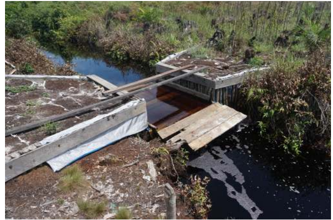
Foto: Sekat kanal yang tidak berfungsi seperti diharapkan karena air mengalir di bagian tengah. Koordinat N 02 1'31.051" E 100 33' 16.707"
