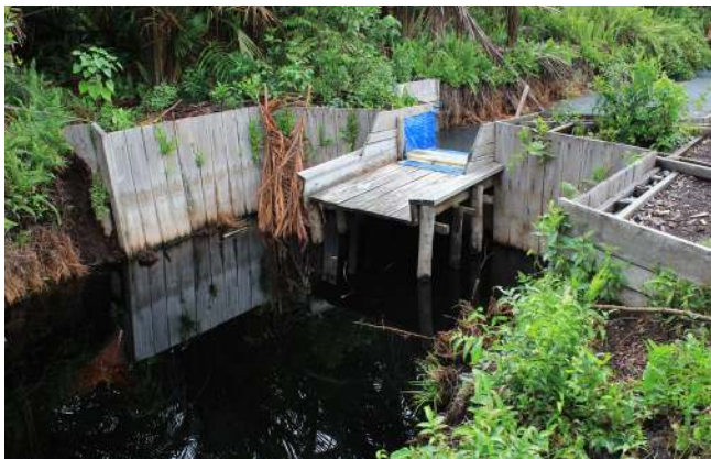
Foto: Sekat kanal bagian dari program pengembangan sistem model tata air terintegrasi kerjasama LPPM Universitas Riau dengan BRG. Koordinat N 00 56,547' dan E 102 48,082'
