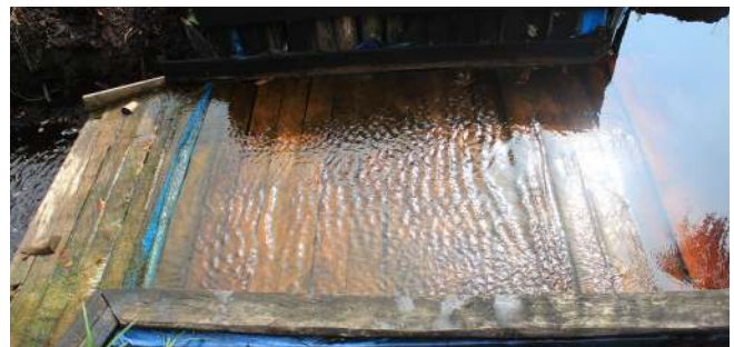
Foto: Sekat kanal dengan kondisi baik di Muara Dua. Koordinat N 01 05'42,45" dan E 102 01'14,34"
