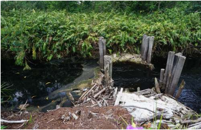
Foto sekat kanal yang rusak dan kering. Koordinat: N 138' 30.077" E 101 44' 11.227" dan N 138' 13.009" E 101 46' 52.161"
