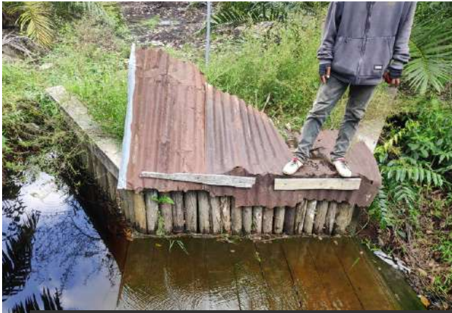
Sekat kanal di KHG Krueng Bubon–Krueng Meureubo, Provinsi Aceh yang (kiri) berkondisi baik dan (kanan) sekat kanal yang dipenuhi oleh belukar.
