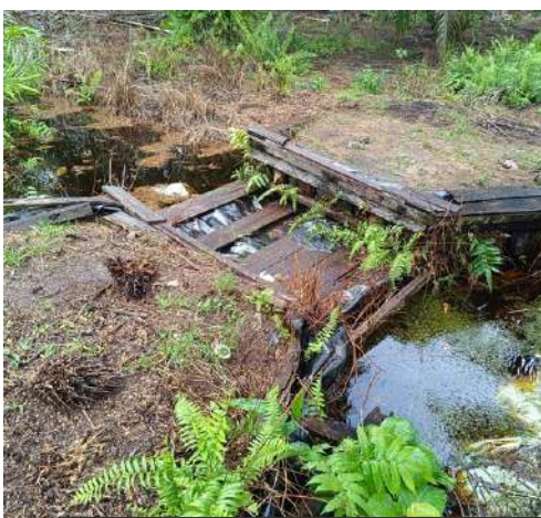
Sekat kanal BRGM berkondisi rusak yang ditemukan pada (kiri) KHG Pulau Rupert dan (kanan) KHG Sungai Rokan–Sungai Siak Kecil, Provinsi Riau.
