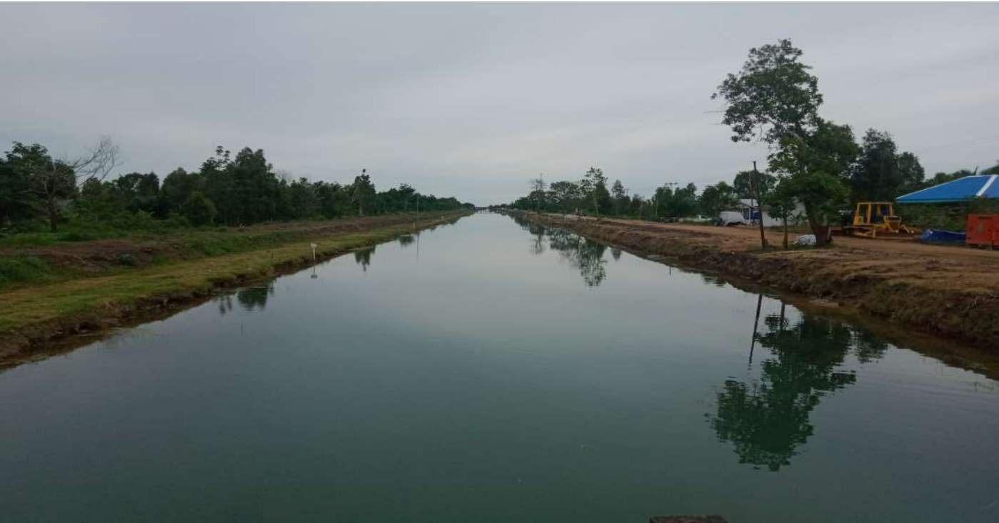
Gambar : Irigasi kanal pasca rehabilitasi di Desa Bentuk Jaya tidak berfungsi karena sistem yang buruk. / The rehabilitated irrigation canal in Bentuk Jaya does not function due to poor system.
