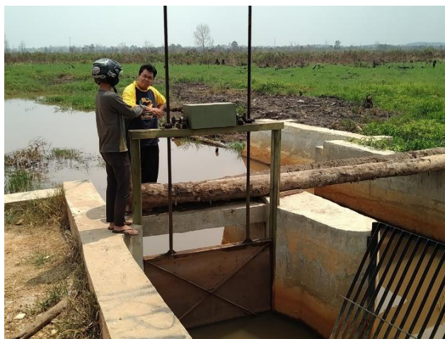
Gambar 28 Penerapan pintu air pada lahan gambut di Liang Anggang.
